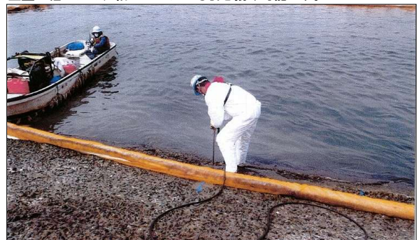
潮の干満で水面の上下により、スロープの油濁汚染を防除するために展張
