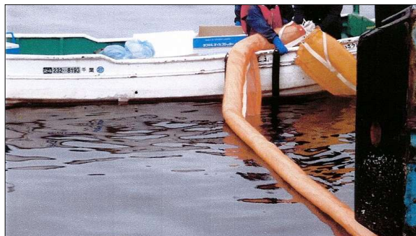
作業艇上でODC-Kを連結（桟橋の後脚を包囲しODC-Kの先端同士を連結作業）
